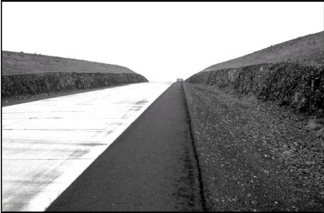
FIG. 5 - Um longo corte de estrada mostra o contato plano entre o basalto e o loess sobreposto. Havia de 10 a 20 cm de pedregulhos entre a superfície de cima do basalto e a camada de loess.
